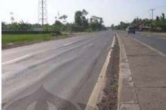
**Gambar II.5** Alur (*Rutting*) Pada Badan Jalan
