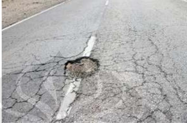
**Gambar II.6** Lubang Pada Badan Jalan
