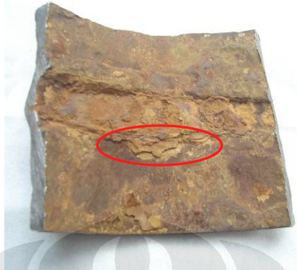
Gambar 4.4 Daerah bocor yang tertutup deposit korosi Pada bagian pipa yang mengalami kebocoran, produk korosi dibersihkan sehingga lokasi bocor dapat terlihat.
