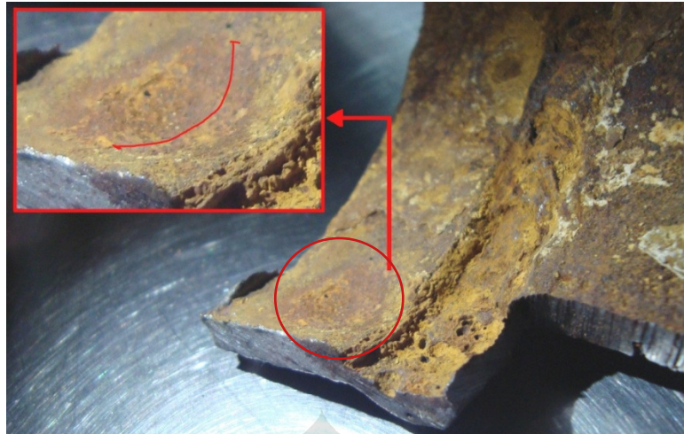
Gambar 4.7 Bagian lasan yang tidak terisi logam las ( incomplete of penetration ) dan penipisan di daerah HAZ
