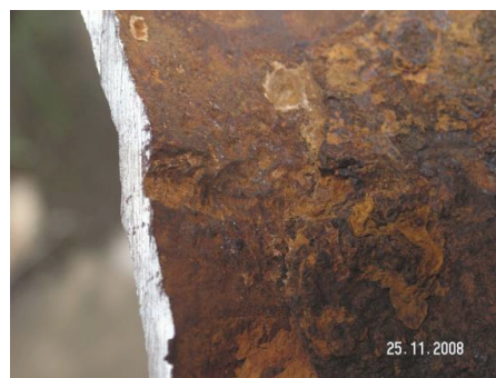
Gambar 4.6 Bagian lasan yang tidak mengalami kegagalan
