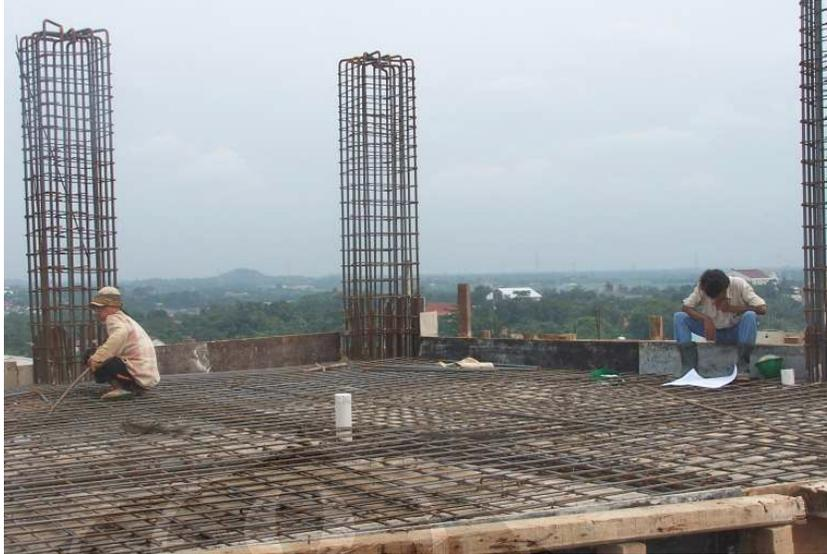
Gambar 2.4. Area kerja (balok & pelat) siap cor setelah pemasangan bekisting dan pembedaan.
