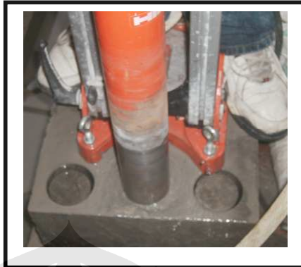
Gambar 5. Pengeboran dengan alat Core Drill
