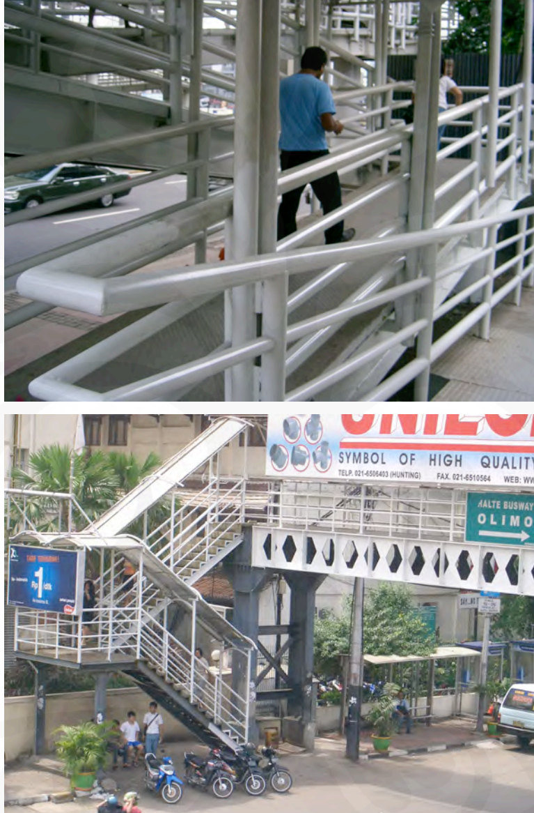
Gambar IV-3. Penggunaan ramp pada jembatan penyeberangan TransJakarta di Jalan Thamrin (atas) dan tangga pada Jalan Gajah Mada (bawah)
