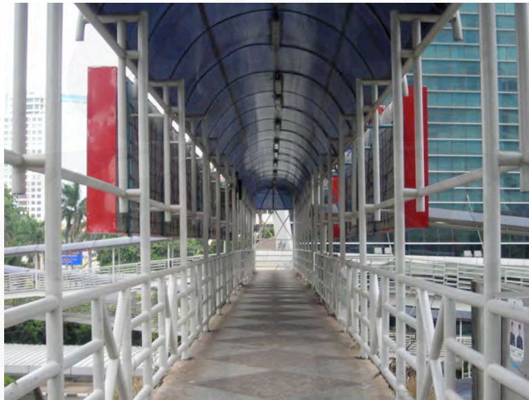
Gambar IV-34. Lebar jembatan 2,5 meter pada halte Patra Kuningan
