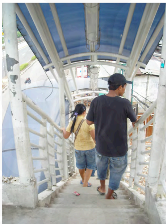
Gambar IV-35. Tangga dengan lebar 1 meter pada halte Depkes
