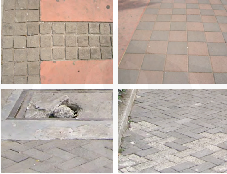
Gambar IV-5. Pola pedestrian sepanjang jalan Sudirman-Thamrin (atas) dan kondisi pedestrian pada Jalan Gajah Mada (bawah)
