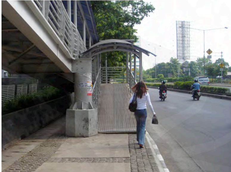
Gambar IV-29. Keberadaan ramp memblokir jalur pedestrian, membahayakan pedestrian
