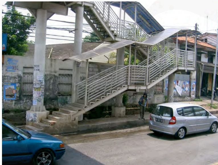
Gambar IV-25. Penggunaan ramp dan tangga pada Jalan HR Rasuna Said (atas) dan Jalan Buncit (bawah)
