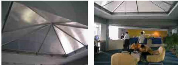
Gambar IV.1. Skylight di area membaca perpustakaan FTUI Sumber : dokumen pribadi
