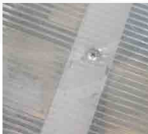
Gambar IV.4. Sambungan menggunakan paku Sumber : dokumentasi pribadi
