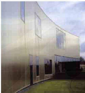
Gambar IV.16. Façade melengkung pada Pusat Dansa Laban Sumber : ElCroquis. hal 82
