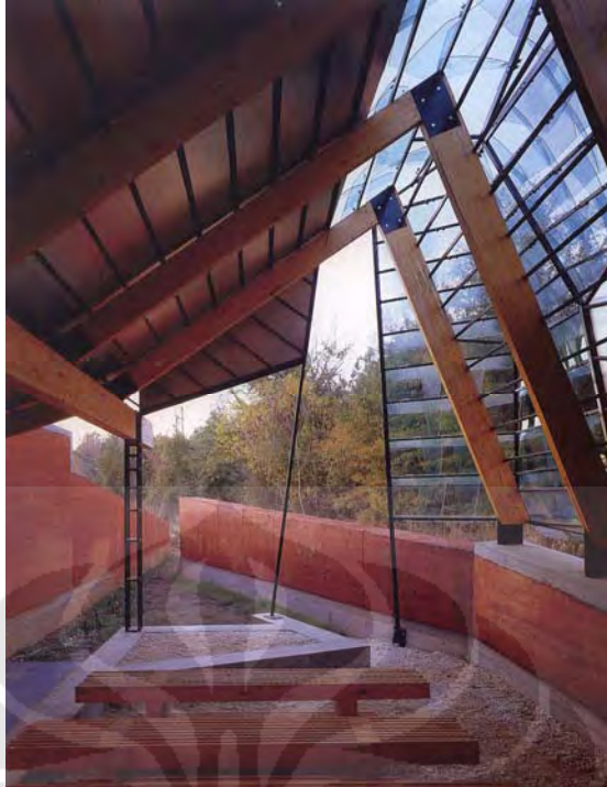
Gambar 10: Kolom dan struktur sekunder dari baja
