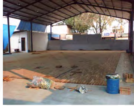
Gambar 33 : Lapangan indoor futsal baru yang sedang dalam masa konstruksi Sumber : Dokumentasi pribadi
