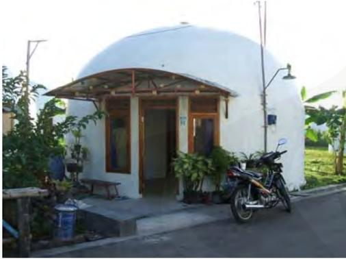
Gambar 13. Kanopi dibuat memanjang dan melebar pada bagian depan dome untuk menghalangi air hujan masuk ke dalam dome dan dimanfaatkan sebagai teras.
