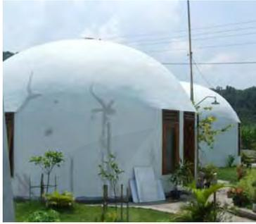
Gambar 42. Lama kelamaan keadaan dinding domanya mulai retak sehingga air hujan merembes ke dalam dome melalui dinding.
