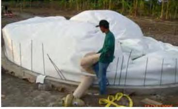
3. Letakkan cetakan dan pompa dengan udara.
