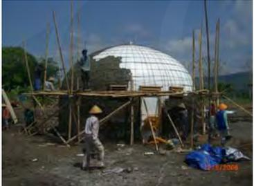
4. Buat rangka dari besi tulangan di sekeliling cetakan dan lapisi dengan beton.
