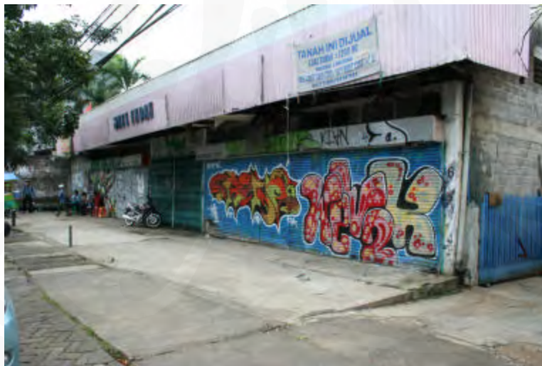
Gambar 18. Toko Jati Indah (sumber: dokumentasi pribadi)
