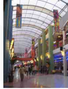
Gambar III.27 Skylight pada bagian city walk (sumber : dokumentasi pribadi)
