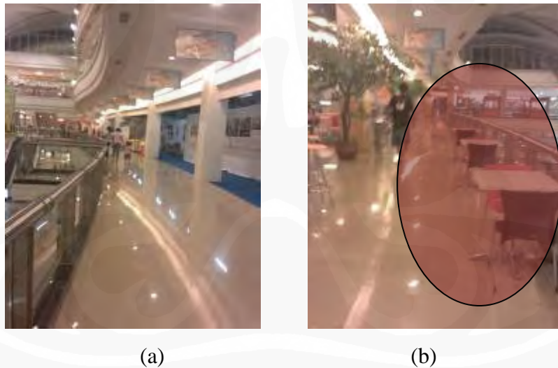
Gambar 3.13 : (a) koridor yang digunakan sesuai fungsinya, (b) koridor yang disalahgunakan pada sebagai area food court .
