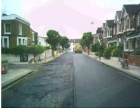
Gambar 2.9 Perkerasan kedap air pada jalan raya dan jalur pejalan kaki
