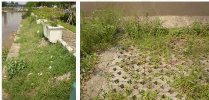
Gambar 3.19 Terasering dengan perkerasan berupa *grasspave* (sumber: dok. pribadi)
