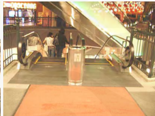
Gambar 3.16 Tampak depan Railing di sekitar eskalator Sumber: dokumentasi pribadi
