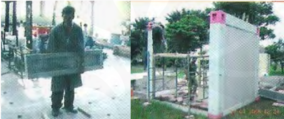
Gambar 11 Komponen RISHA dengan satu orang tenaga kerja Sumber : Pusat Penelitian dan Pengembangan Permukiman Dep. PU
