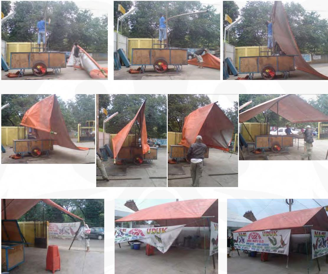
Gambar 17. Proses pemasangan naungan
