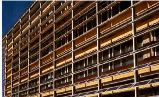
Gambar.53 Jarak antara panel fotovoltaik yang mengikuti lebar ruang di belakangnya.
