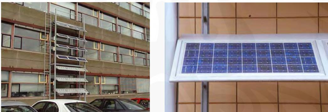
Gambar.48 Peletakan panel fotovoltaik pada fasade dengan *hybrid awning system*.
