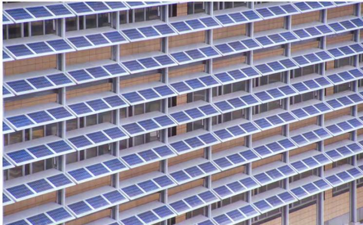
Gambar.50 Penyusunan panel fotovoltaik pada fasade juga sebagai *sun shading*.
