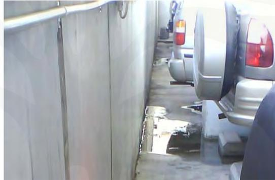
Gambar 79: Adanya genangan air pada sudut parapet dengan lantai
