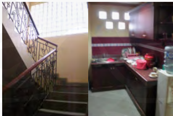
Gambar 30. Penggunaan glass-block agar cahaya matahari dapat masuk hanya dapat dilakukan ruko yang berada di ujung.
