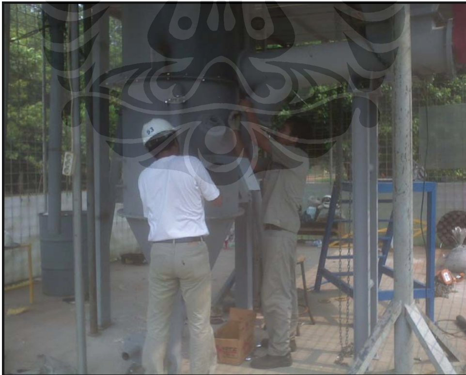
Proses instalasi selesai dilakukan
