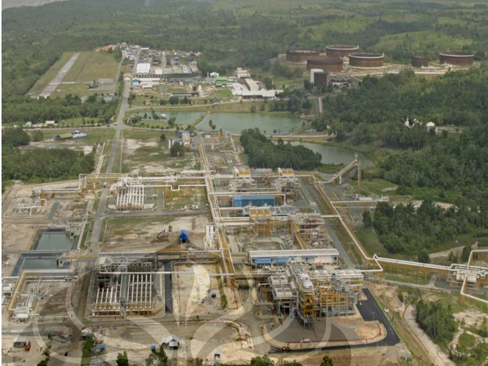
Gambar 5.5. Terminal Minyak dan Kondensat Senipah
