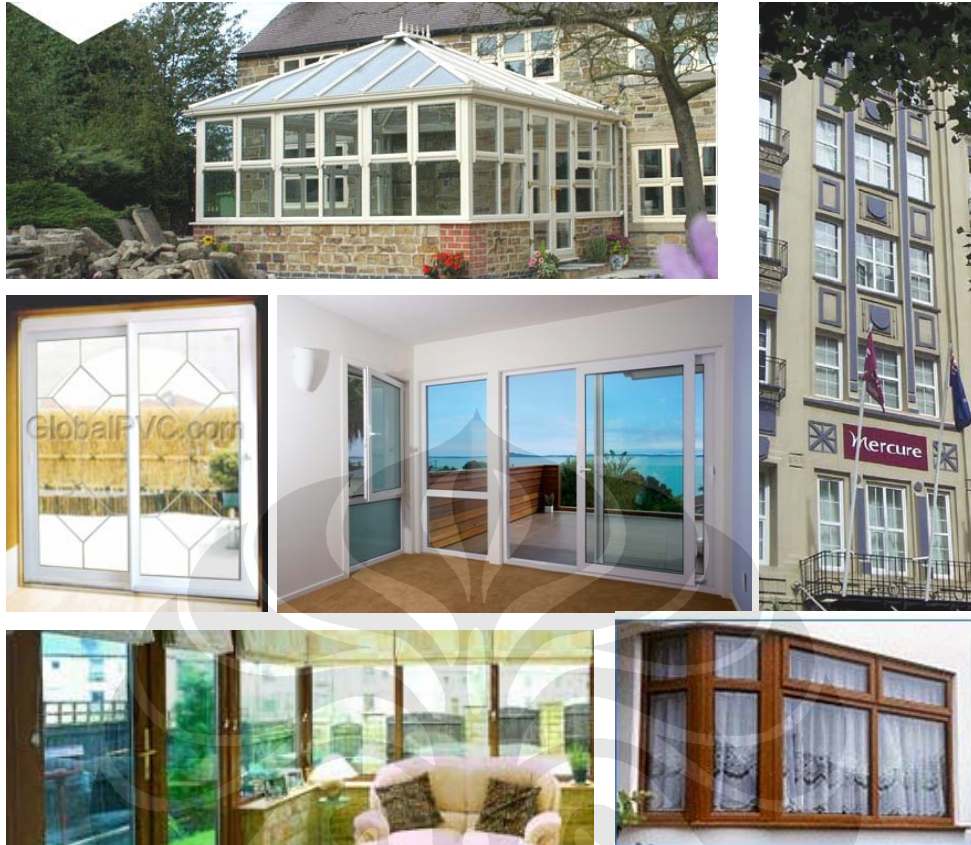
Gbr. 11 : Contoh Aplikasi Kusen Berbahan PVC Dalam Bangunan Sumber : internet (berbagai website)
