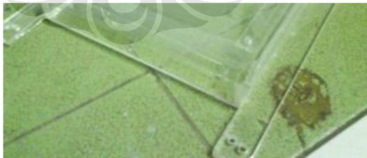
**Gambar 5.2** Lubang baut yang diperbaiki
