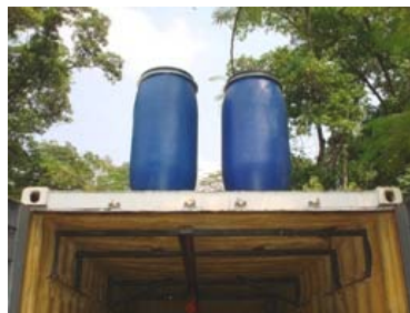
Gambar 3.11 : Posisi water reservoir pada peti kemas
