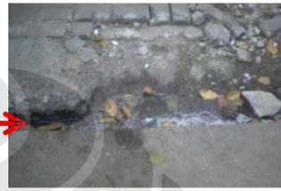
Gambar 3-52. Saluran drainase yang tidak terintegrasi, hanya berupa garis disamping *curb* jalan. (sumber: dok. Pribadi)
