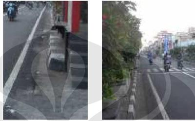
Gambar 3-24. Sistem drainase yang terintegrasi dengan zona ini dan mempunyai ketinggian yang dapat menghambat kendaraan bermotor yang sesuai dengan teori (sumber: dok. Pribadi)
