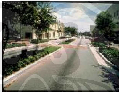
Gambar 2-5. Mempersempit jalan dengan menggunakan median ( sumber : www.pps.org/info/placemakingtools/casesforplaces/livememtraffic )
