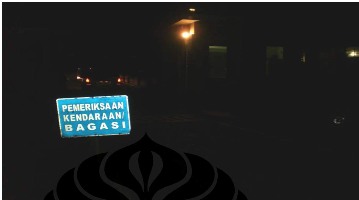
Foto 30: Papan pengumuman pemeriksaan kendaraan/bagasi pada pos kontrol. Hal ini sdh tidak dilaksanakan lagi demikian jg penerangan lampu jalan yg minim pd pos kontrol tersebut.
