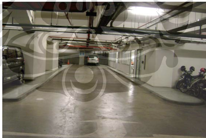
Gambar 6.18 Kondisi Lantai Basement Gedung 3
