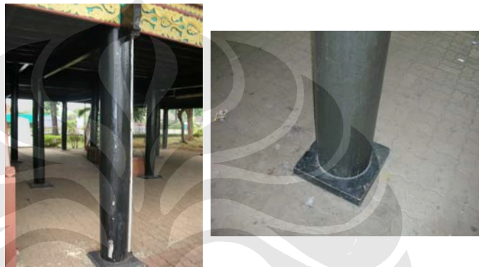
Gambar 4.4 Bentuk Tiang Rumoh Aceh , Tiang Diletakkan Diatas Batu
