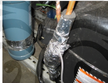
Gambar 4.18 Pemasangan probe termometer digital
