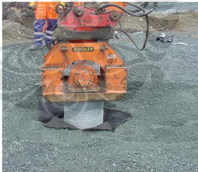
Gambar 2.2.5.b. Pemasangan Selubung Baja
