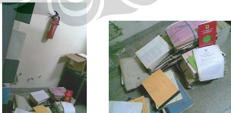
Gambar 4.7 Hydrant diatas tumpukan buku
