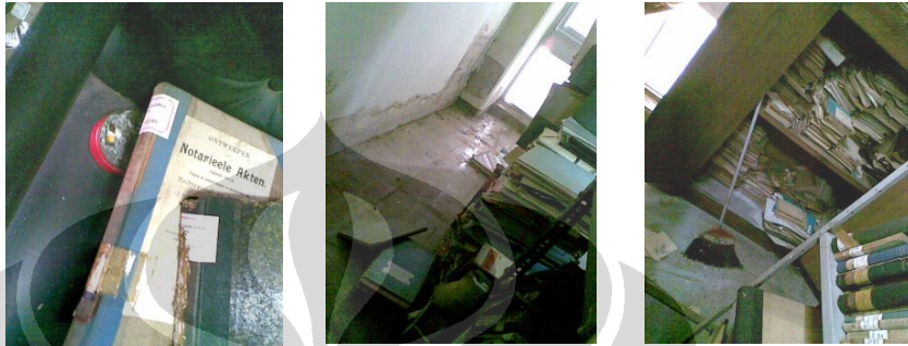
Gambar 4.12 Kondisi ruangan yang tidak tertata
