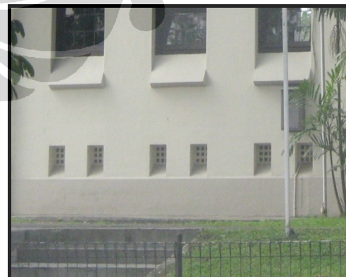
Foto 2.28. Lubang Ventilasi Ruang Konsistori (Dok: Albertus Napitupulu, 2008)
