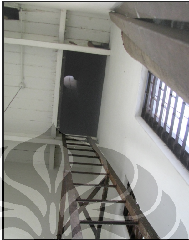
Foto 2.24. Tangga Pada Ruang Menara (Dok. Albertus Napitupulu, 2009)
