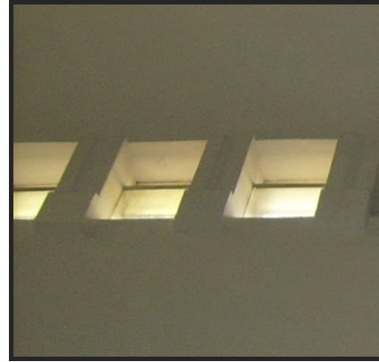
Foto 2.26. Lubang Ventilasi Pada Langit-Langit (Dok: Albertus Napitupulu, 2008)
