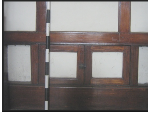
Foto 2.29. Penutup Lubang Ventilasi Bawah Pada Ruang Jemaat (Dok: Albertus Napitupulu, 2008)
