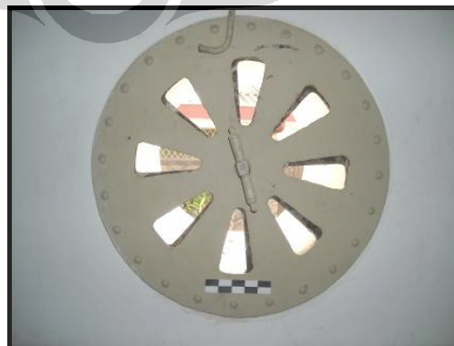
Foto 3.11. Lubang Ventilasi Dengan Penutup Pada Gereja Santa Perawan Maria Bogor (Dok: Cheviano, 2008)
