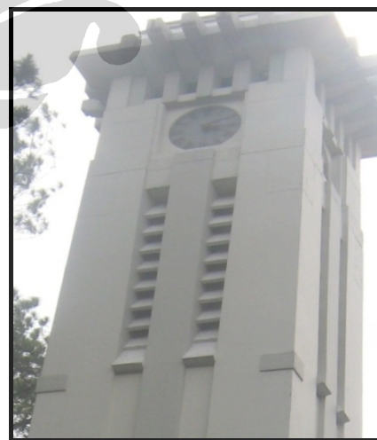
Foto 2.31. Lubang Ventilasi Pada Menara (Dok: Albertus Napitupulu, 2008)
