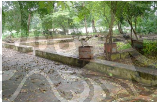
Foto 2.8. Pondasi pada bangunan Tasik Ardi (Bunga Masripah, 2008)
