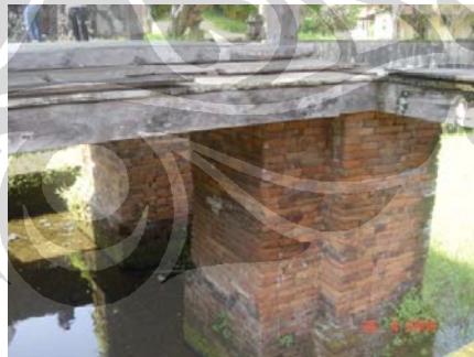
Foto 2.15. Pondasi atau kaki bangunan Bale Kambang Gua Sunyaragi (Renaldo Zoro, 2008)
