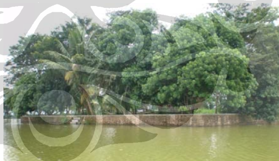
Foto 2.7. Turap dinding utara bangunan Bale Kambang Tasik Ardi di Banten (Renaldo Zoro, 2009)
