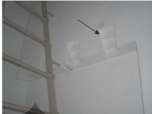
Foto 3.37. Hiasan colonial casing pada dinding menara GSPM (Dok: Cheviano Alputila, 2008)
