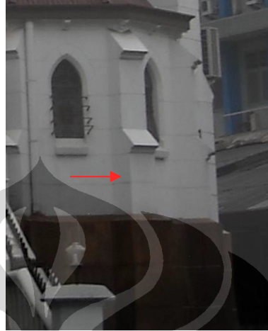
Foto 3.18. Buttress pada ruang perlengkapan misa (Dok: Cheviano Alputila, 2008)
