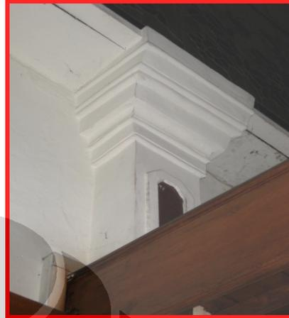
Foto 4.3 Pilaster penyangga (tampak bagian atas)
