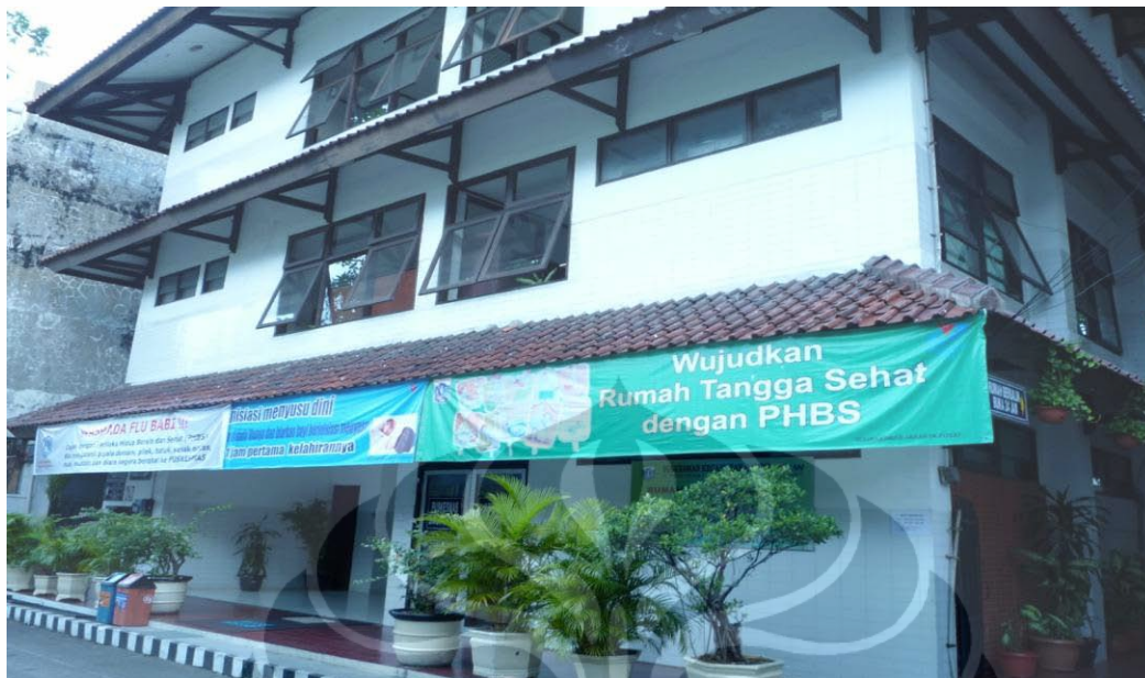
Gambar 4.2 Gedung Puskesmas Kecamatan Gambir
