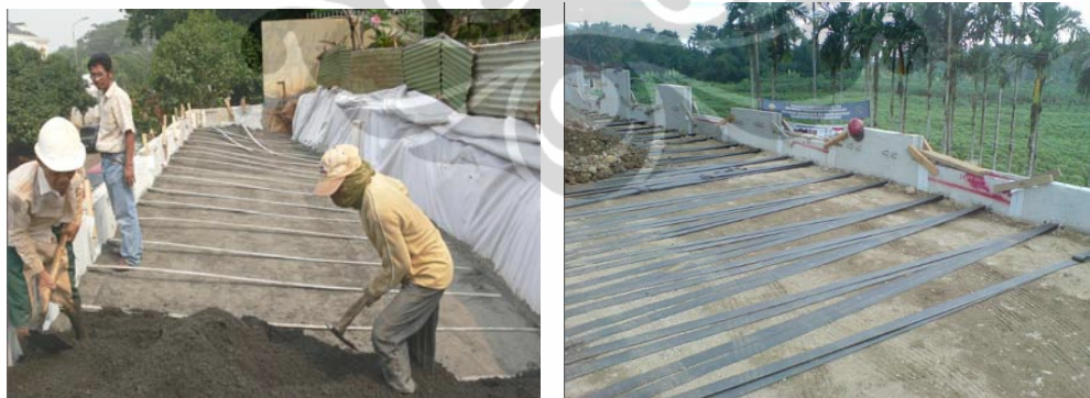
Gambar 6.11. Aplikasi Kedua Jenis Material Perkuatan Tanah Yang Diuji
