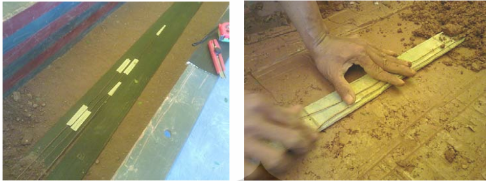
Gambar 5.16. Pemasangan Kawat Nickel
