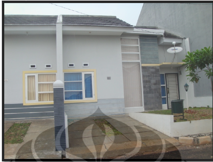
Gambar 4.5 Tampak depan rumah tinggal perumahan Permata Cimangis cluster Jamrud tipe 38 dengan menggunakan atap genteng beton flat monier (Sumber: data penelitian, 2009)
