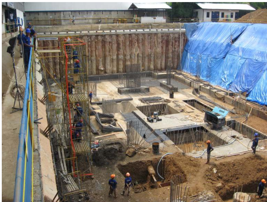
Gambar 6.9 Pembuatan Lantai Basement
