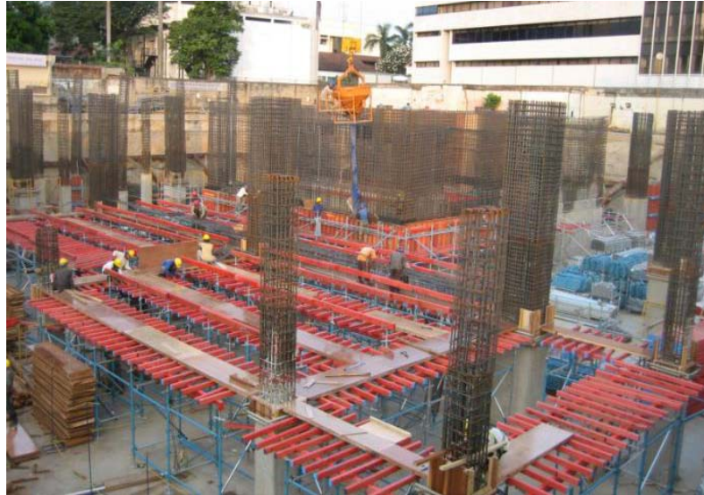
Gambar 6.11 Pemasangan Begisting
