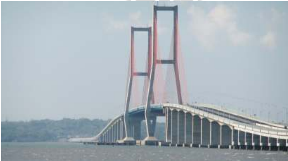
Figure. 6. Le pont de Suramadu
