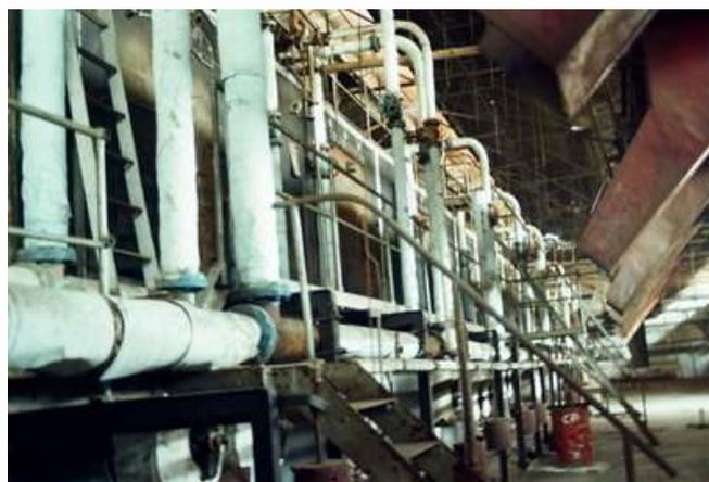
*Foto .3.28. Pipa-pipa Besi Untuk Mengalirkan Uap di Dalam Bangunan A1
