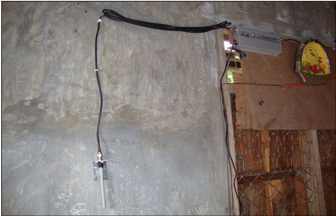
Perangkat Indoor Repeater di Desa KPU/USO ST 2 A dan ST 2 B
