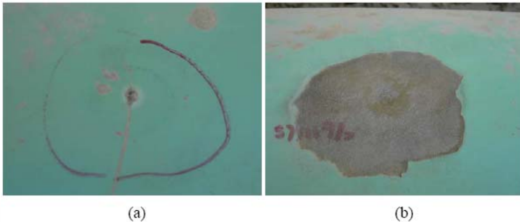
Gambar 2.18. Lapisan FBE yang mengalami Cathodic disbondment , (a) dengan holiday (b) area yang sama setelah blister di lepaskan (22)
