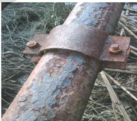
Gambar 4.1 Korosi berat pada KP 6.4 dengan repair clamp
