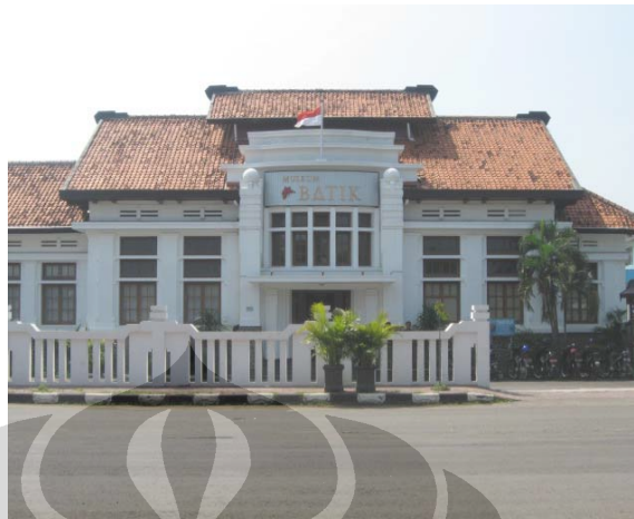
Foto 3.1. Bangunan Utama Museum Batik di Pekalongan (Sumber: Museum Batik di Pekalongan, 2010)
