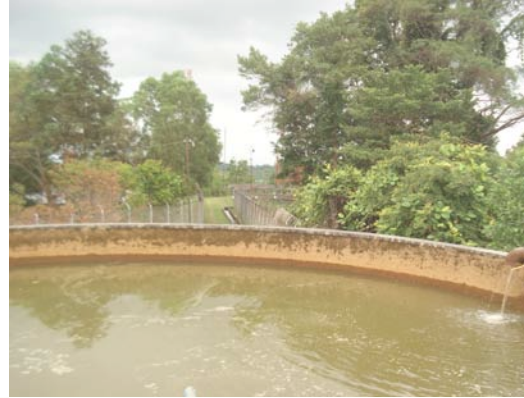
Foto 4.14 Kolam Penampungan/Pengendapan Air di Puncak Bukit Skip Sebelum Diproses Menjadi Air Bersih. (Foto: Salam 2010)
