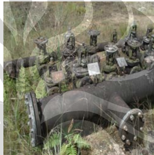
Foto 4.16 Pipa Penyaring Fluida Reservoir Untuk Membagi Minyak, Air dan Gas. (Foto: Salam, 2010)
