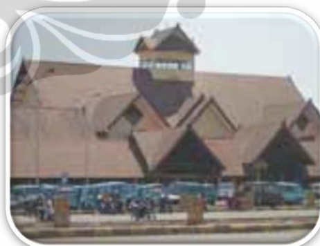
Foto 4.22 Prasarana Transportasi “Terminal Regional Daya”. Sumber: Profil Kota Makassar, 2010: 13
