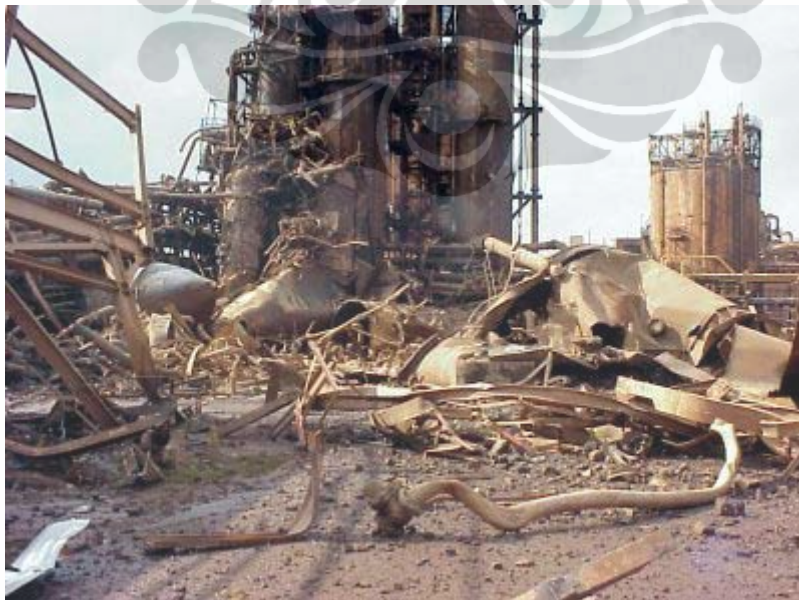
Gambar 1.2 Ledakan di pabrik alumina di kota St. James, Louisiana
